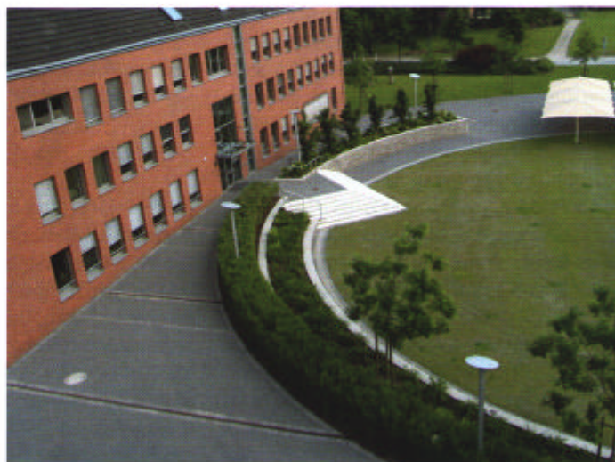
Rasenkammersteine machen den Platz „allwettertauglich“, Schirme lassen sich in einem Raster von 5 x 5 Metern in Bodenhilfen je nach Bedarf aufstellen.
